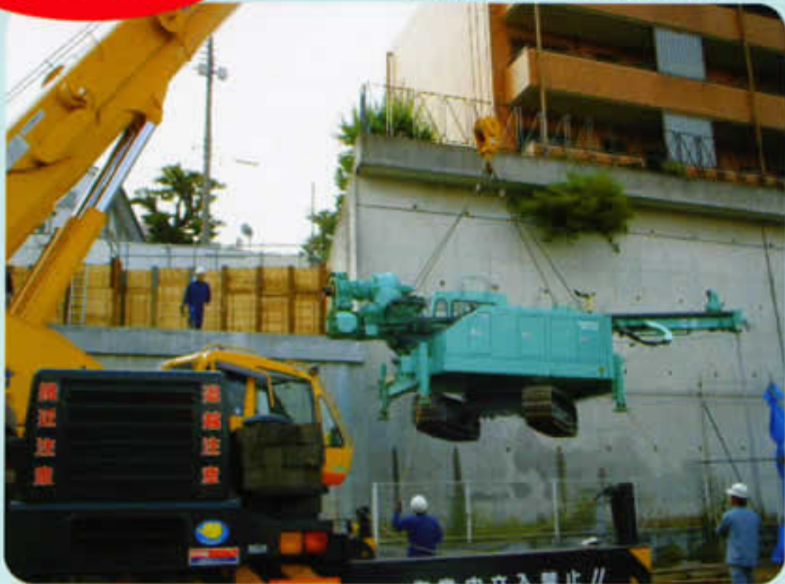
重機の吊上げ搬入(約14t)
