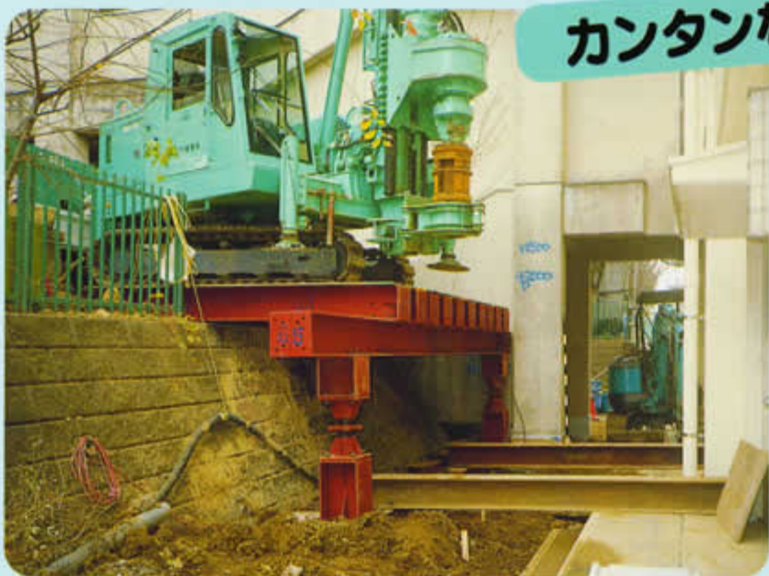
そこに杭芯さえあれば…(乗入構台より作業する)
