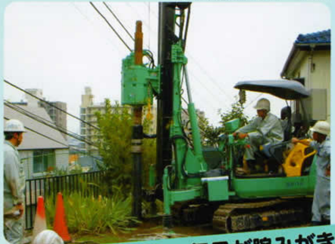
最小重機施工(ℓ=14m)
